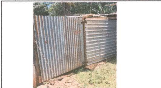
Foto 3 Sustrucción de portón por metal
