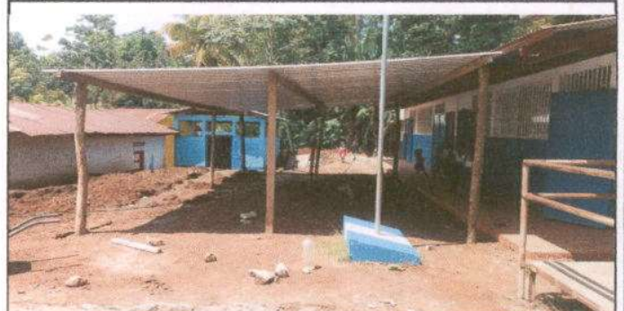
Foto 2: Sustrucción de estructura de soporte de madera, por metal
