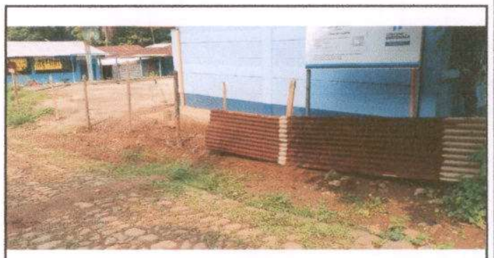
Foto 6: Sustrucción de muro perimetral
