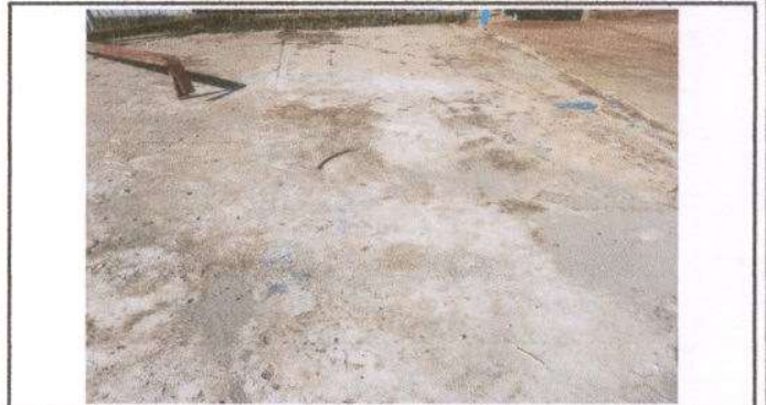
Foto 4: Sustrucción de torta de concreto
